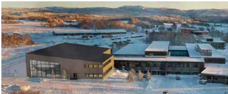
Nytt tilbygg for å huse den nye flyfaglinjen er under oppføring.
